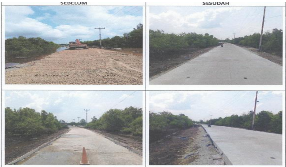
Salah satu Pengerjaan Jalan di Kabupaten Kepulauan Meranti
